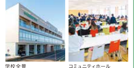
学校全景 コミュニティホール
