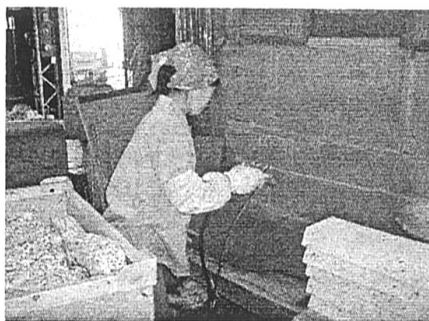
接着剤の吹付け作業
