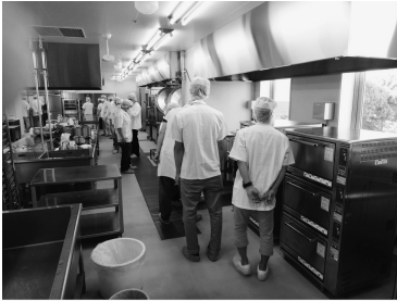
厚生連で唯一のオール電化調理室です。ガスも蒸気も一切無いです。
